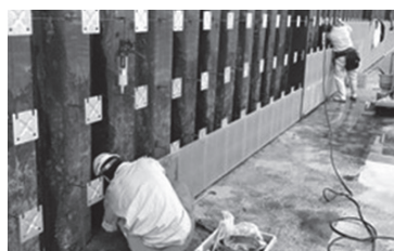
農林水産大臣賞 パネル被覆工法「ストバネ工法」によ る腐食鋼矢板水路の補修・迅速再生 技術の開発 藤村クレスト株式会社
